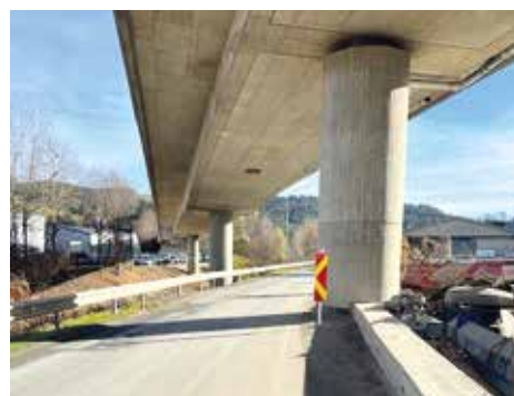
Errichtung einer Warnbake vor dem Brückenpfeiler in der Ruhmannstraße
