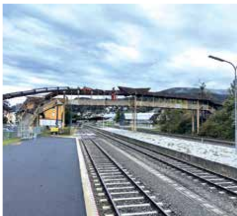
Der Fußgängerübergang am Bahnhof
