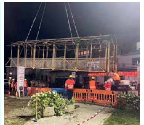
Die Teile wurden mittels Krans verladen
